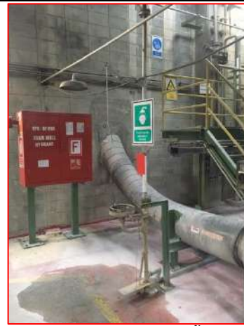
ภาพที่ 2.2-29 ฝักบัวและอ่างล้างตาฉุกเฉิน
