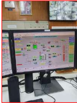
ภาพที่ 2.2-2 ระบบควบคุมอัตโนมัติ ในการเปิด/ปิดวาล์วนิรภัย
